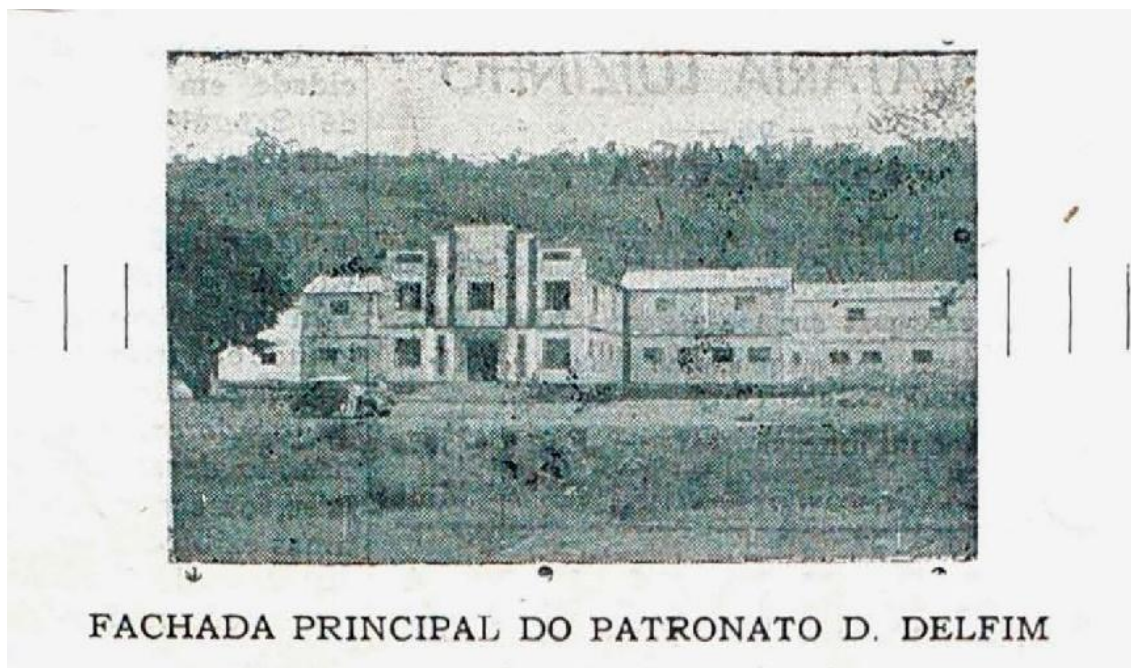
Figura 6: “Fachada Principal do Patronato D. Delfim”, 1952.
